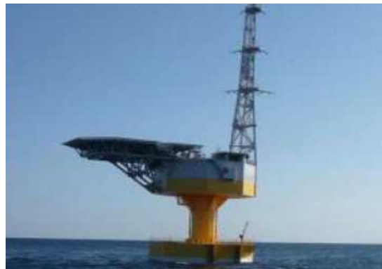
[그림 78] 부유식 해상 변전소 Fukushima Kizuna
