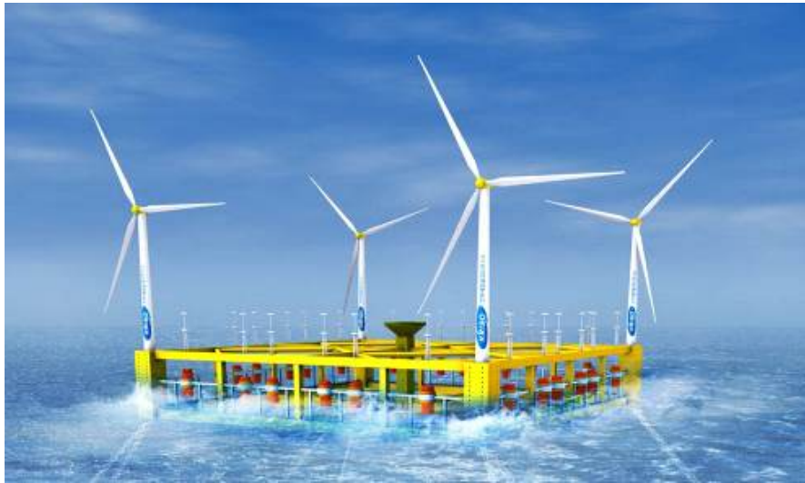
[그림 35] KRISO에서 연구 중인 10MW 복합발전(풍력-파력에너지) 플랫폼
