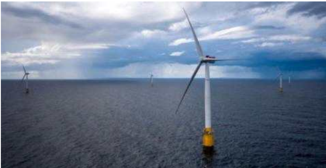
[그림 50] 세계 최초의 부유식 해상 풍력 발전소인 하이윈드
