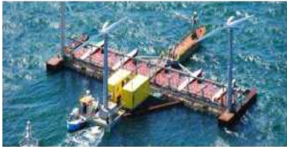
[그림 4] 파력-해상풍력 복합발전 사례(덴마크 포세이돈 및 영국 Green Ocean Energy)
